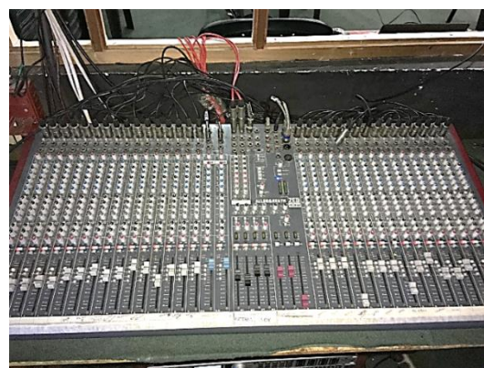
Ilustración 19. Consola Allen and Heath instalada en la congregación “Abba Padre” Fuente: Elaboración Propia
