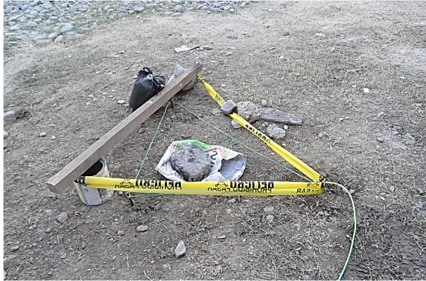
Figura 43. Tierra física (Delta) tomado del centro de carga general, en los festivales Unitronica y Unirock 2019
