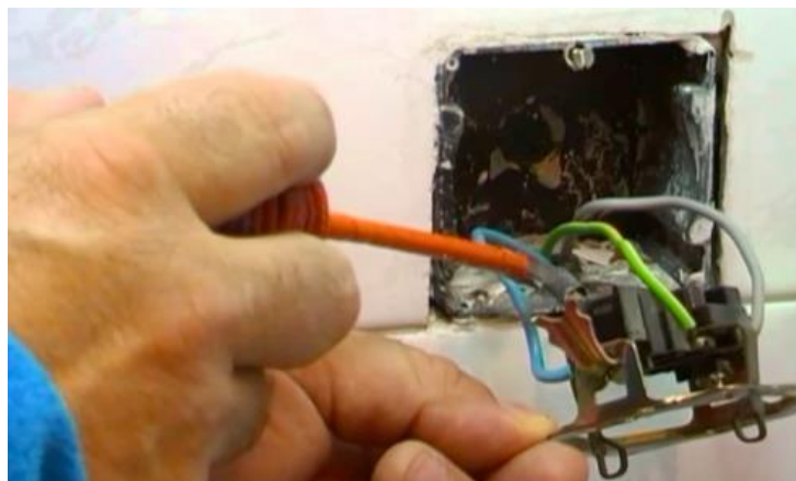
Figura 56. Enchufe monofásico. Cable gris: fase. Cable azul: neutro. Cable verde: tierra.
