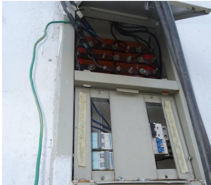
Figura 38. Tablero Monofásico
