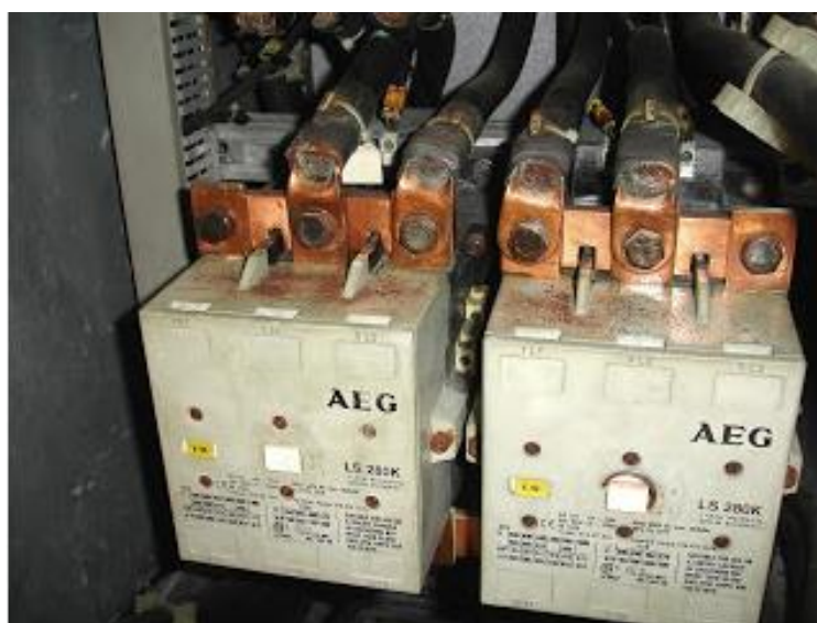
Figura 15. Sistema arrancador de un motor
