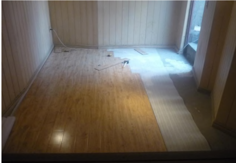
Foto N° 20 Vista del proceso de la Instalación del piso flotante.
