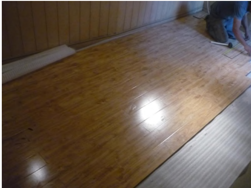
Foto N° 21 Vista del proceso de la Instalación del piso flotante.
