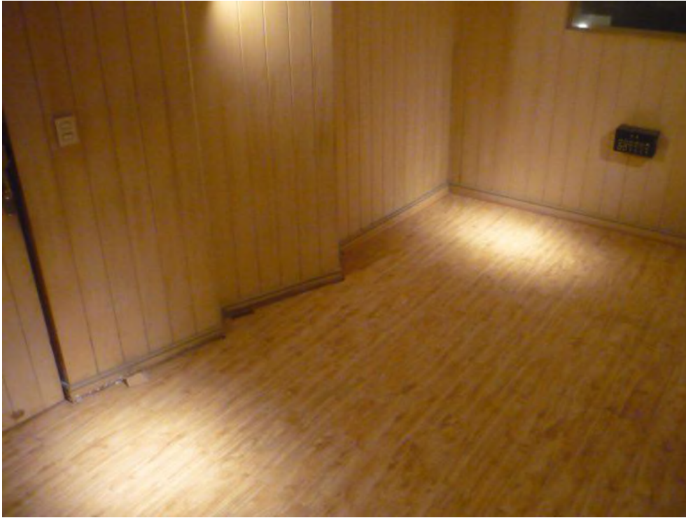
Foto N° 22 Vista del Piso Concluido en su Instalación.
