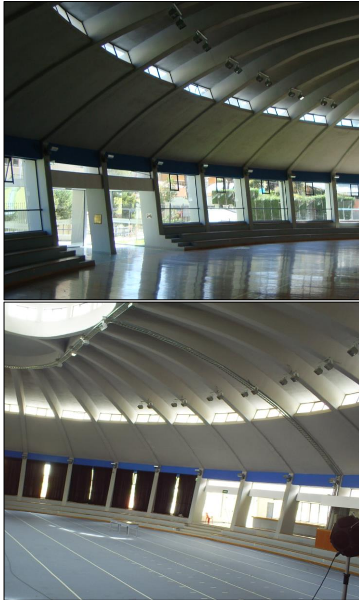
Figura 31. Paredes Laterales Coliseo SAS.
