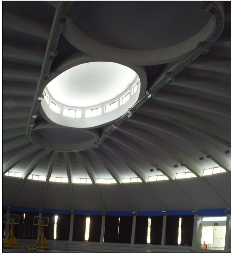
Figura 30. Cubierta Coliseo S.A.S.
